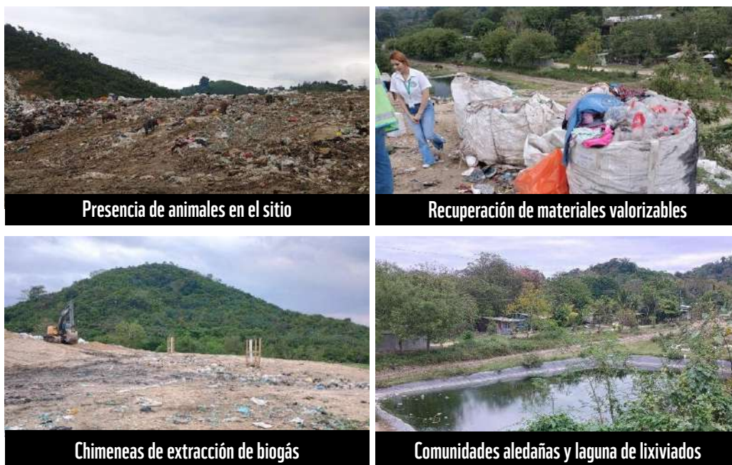
Imagen 19. Condiciones actuales del sitio de disposición final.
