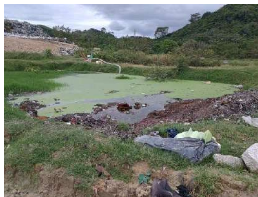
Trinchera para lodos y cenizas
