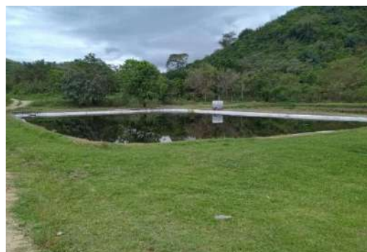
Laguna de evaporación de lixiviados
