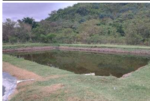
Laguna de alivio para lixiviados y agua lluvia
