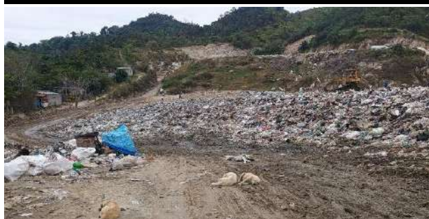
Accesos en mal estado por las lluvias
