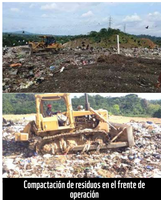
Imagen 17. Proceso de manejo de los residuos sólidos en el relleno sanitario.
