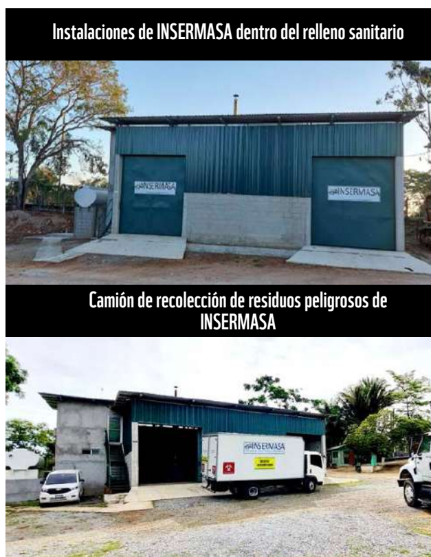
Imagen 18. Instalaciones del incinerador de residuos peligrosos en el relleno sanitario.
